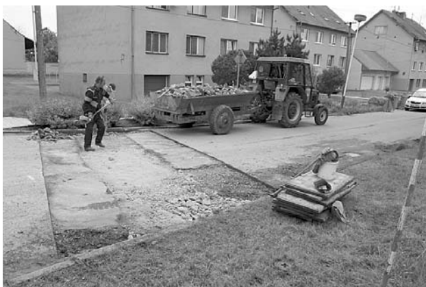
Opravy komunikace na křižovatce ulic Herbenova a Bratří Mrštíků.
