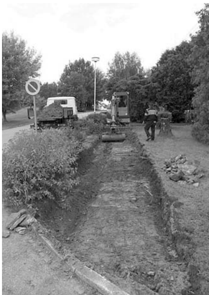
Zahajovací práce na rekonstrukci chodníku na ulici Bratří Mrštíků.
